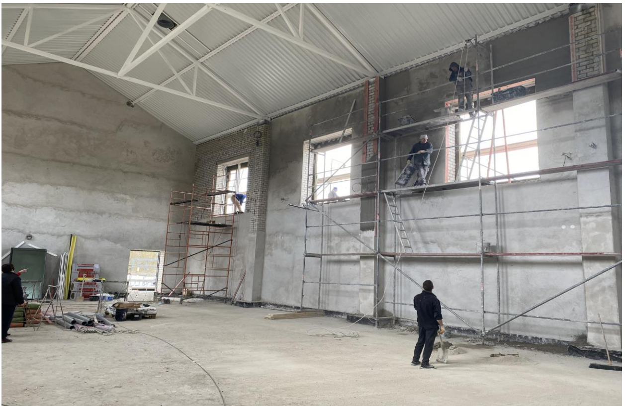
Пристройка спортивного зала к школе пос. Ушаково Озерского района, расположенной по адресу: Калининградская обл., Озерский район, пос. Ушаково, ул. Луговая. д. 21.
