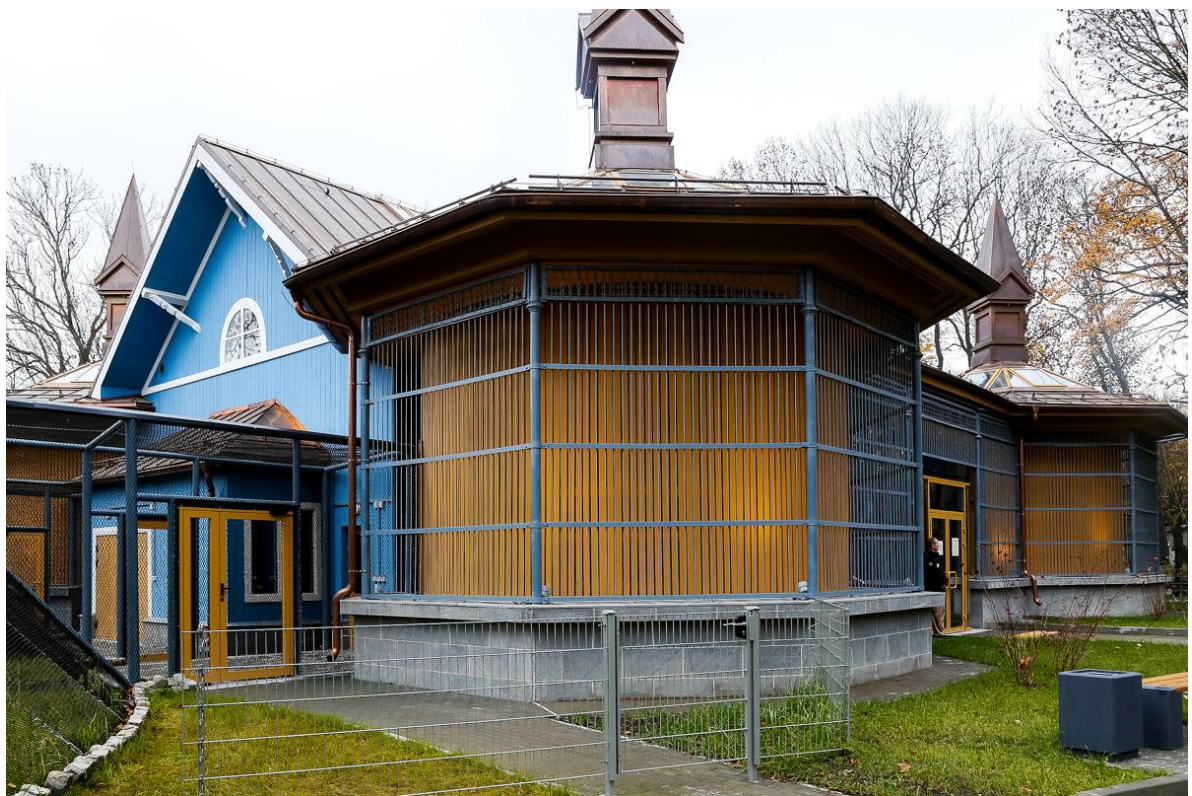
Реконструкция объекта «Львятник» под «Дом тропической птицы» Калининградского зоопарка (г. Калининград)
